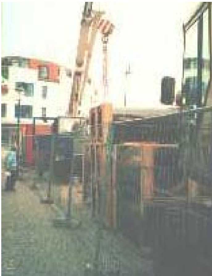
Ursprünglich war vorgesehen, lediglich 70 Meter des neuen Sammlers in der geschlossenen Bauweise herzustellen.
